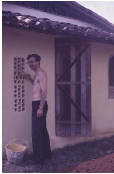
1987: Alois Mahl beim Häuserbau in Alagoinhas
